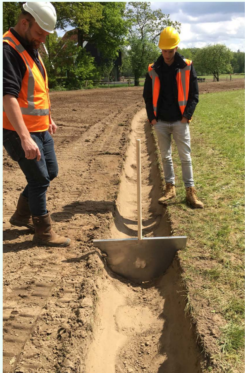
In het uitbreidingsplan op landgoed Het Lankheet (de Veddersweiden en de Sleen) worden nieuwe vloeigoten gegraven
